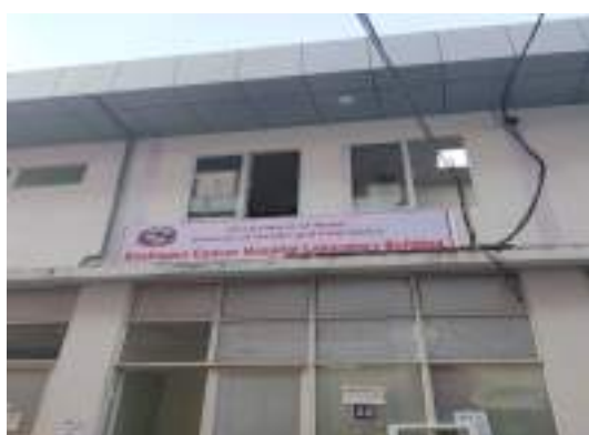
ल्यावको नवनिर्मित भवन
