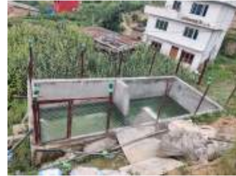
सौडोल लिफ्ट सिंचाइ पानी टंकी मर्मत, चा.न.पा. ९-मर्मत सुधार कार्य
