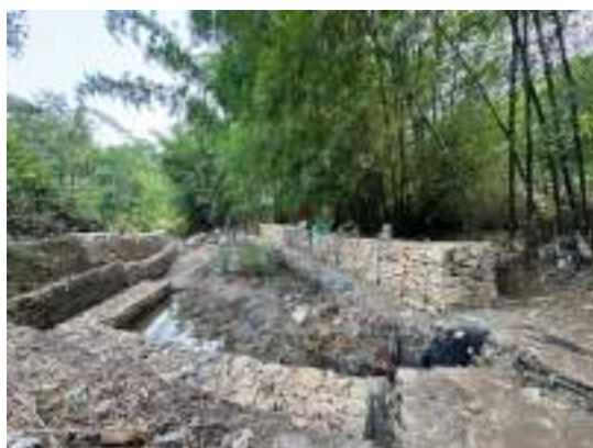
गिता मन्दिर रन्जितकारटोल, चा.न.पा. ७ Gabion -61m
