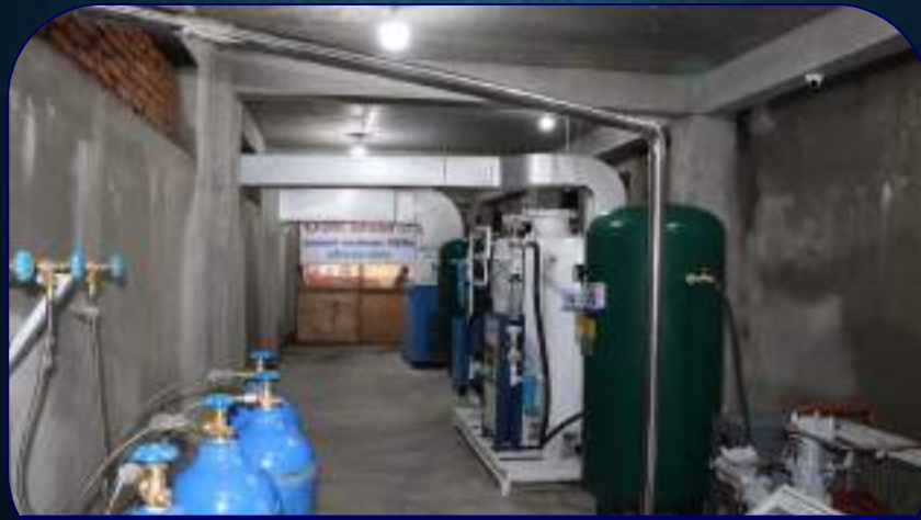
अवसीजन प्लान्ट स्थापना
