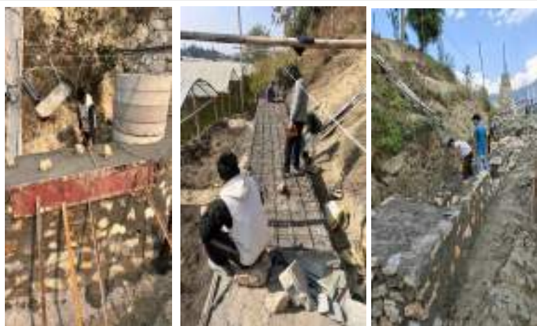
महेन्द्रग्राम मा.वि. वरीपरीको पहिरो नियन्त्रण कार्य चाँगुनारायण ८,RRM वाल- ३६ मि
