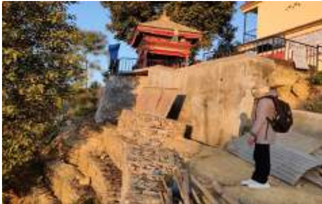
भिमसेन स्थान पहिरो नियन्त्रण सु.न.पा.-७ Plump वाल-२१ मि.,gabion २२ मि
