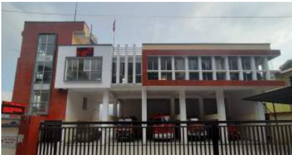
जुद्ध बारुण यन्त्र कार्यालय भक्तपुरको प्रशासनिक भवन
