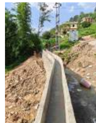
ननावू सिंचाइ, सू.न.पा. ८ ३२ मि RCC lining, ९ मि gabion
