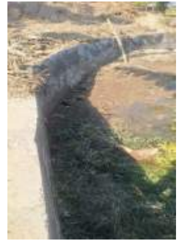
तब्ब्याखुशी खोला नियन्त्रण, सु.न.प.१० Plump wall-४५मि.
