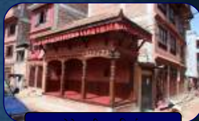
छोसे पाटी पुनःनिर्माण
