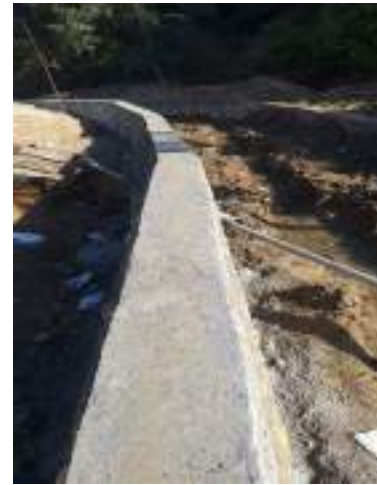
चित्तपोल उडोल ठाडो खोला नियन्त्रण, सु.न.प.१०- Plump wall-१० मि.
