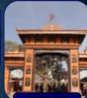
हनुमानघाट ध्वाका पुनःनिर्माण
