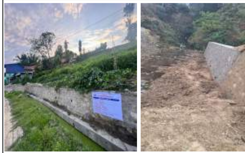
कुटुडल सिंचाइ, चा.न.पा. ७-८६ मि.Rcc lining
