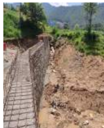
ननावू सिंचाइ, सू.न.पा. ८ ३२ मि RCC lining, ९ मि gabion
